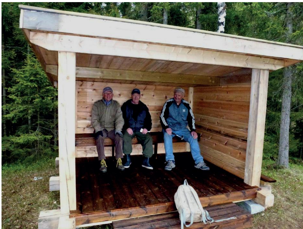
Fornøyde håndverkere tar en pust i bakken i ferdig gapahuk oppe på Høgkleiva. Torbjørn Torgersen, Arne Martinsen og Jon Ødegård.
